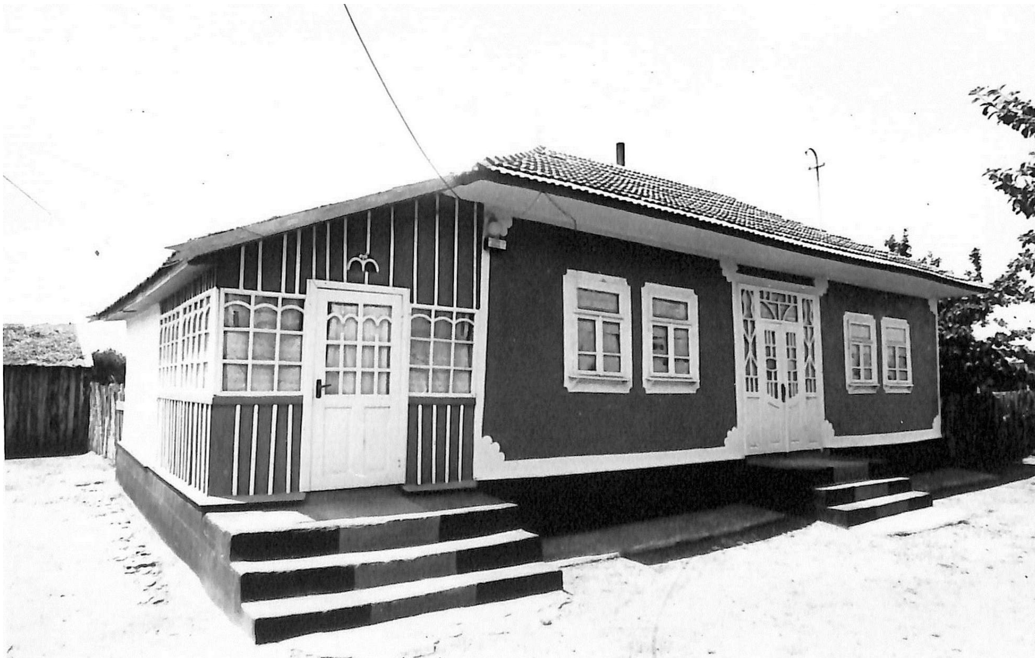
Casă cu elemente tradiționale și cu verandă anexată. Satul Șarbaca, raionul Râșcani. Cercetări etnografice de teren. ASCASM 1975. Fondul 24, inv.18, f.128.
