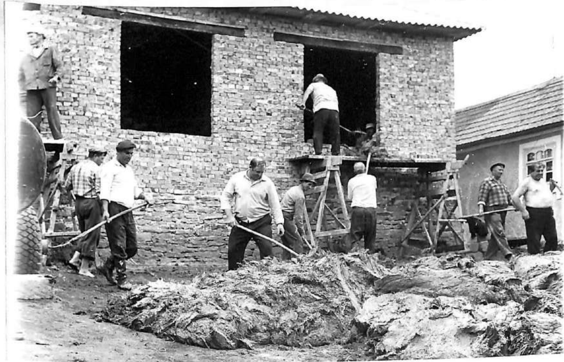
Помощь (кляк) на строительстве жилого дома с. Кирובה Окницкого района ЛССР
