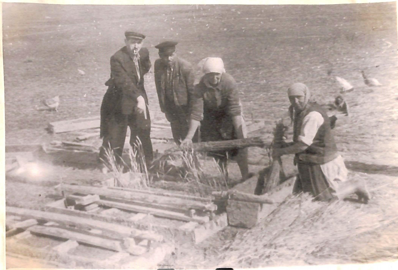
Изготовление глино-соломенных плит в колхозе им. Мланова с. Пынзарены Фалештского района.
